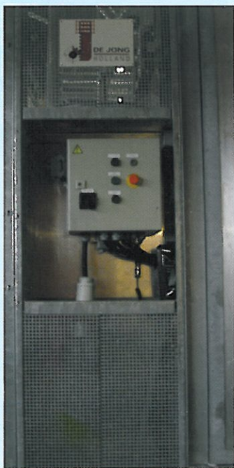
Bedieningspaneel van grondstation. Eventueel afsluitbaar met vandalismeklep (optie).
