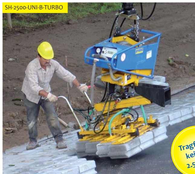
Abbildung oben: Verlegung von Deckwerksteinen mit Sondersaugplatte
